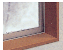
取付け前 外窓のみ
